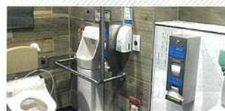
バリアフリートイレ(車いす使用者対応トイレ)
