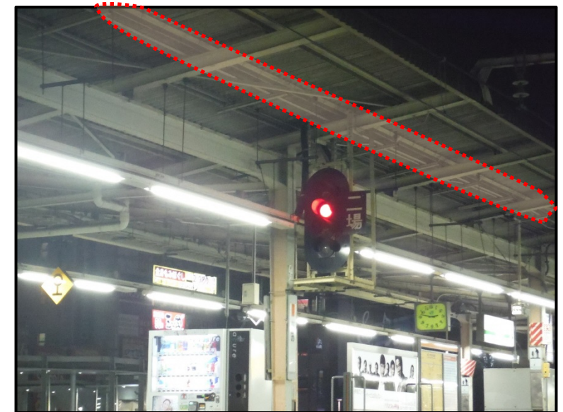
上家ケーブル移設
