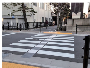
道路(エスコートゾーン)
