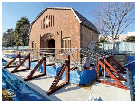
▲旧中野刑務所正門(工事中)
