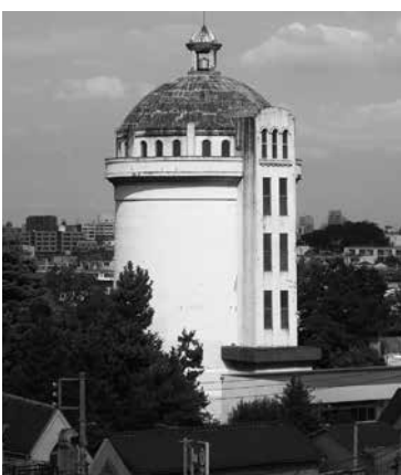
外壁には空襲時の弾丸の傷跡が残っています
