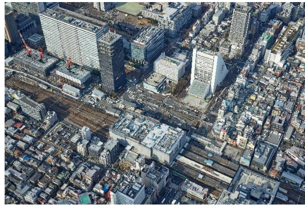
▼中野駅橋上駅舎・駅ビル 現況
