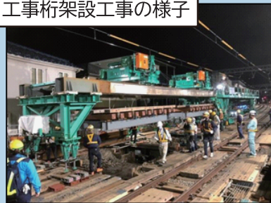
工事桁架設工事の様子
