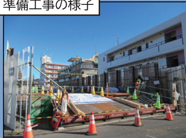
準備工事の様子
