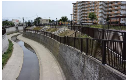
白鷺せせらぎ公園付近
