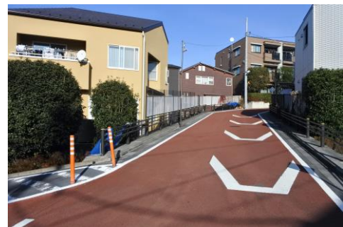
区画道路(平和の森公園周辺地区)
