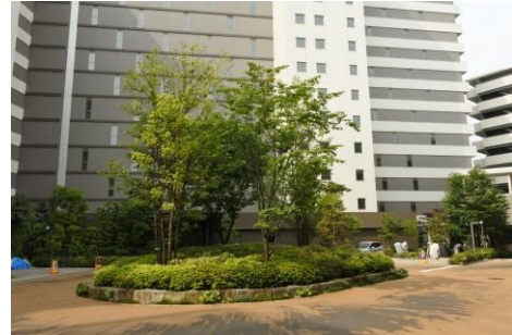
「多世代により育まれる持続可能な地域をつくる」をコンセプトにする「江古田の杜」プロジェクトのサービス付き高齢者向け住宅
