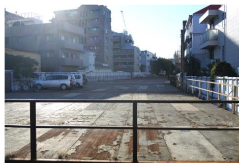
神田川の改修工事
