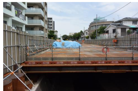
妙正寺川の河川改修
