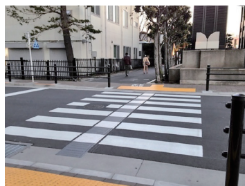
道路(エスコートゾーン)
