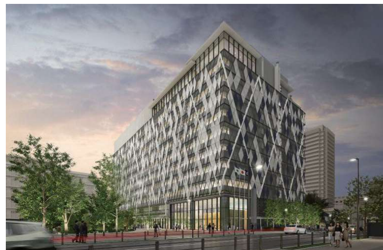
敷地南西側の外観イメージ（夕景）
