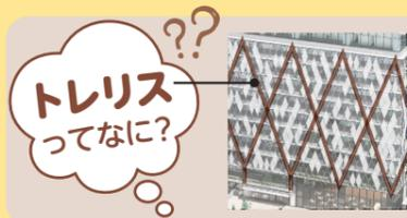
建物の外側に取り付けた構造フレームである“トレリス”は庁舎の耐震性能を向上させるとともに、環境制御パネルを支える部材としても使用されています。
