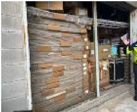
備蓄倉庫の写真（第七中学校）
