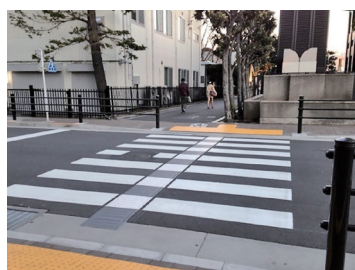
道路(エスコートゾーン)
