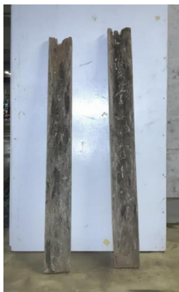
写真4 聯の劣化状況
