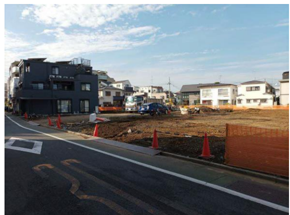
写真2 解体後の様子
