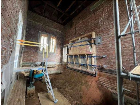
写真3 元守衛室掘削の様子
