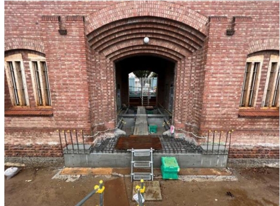
写真4 通路部分の基礎補強の様子
