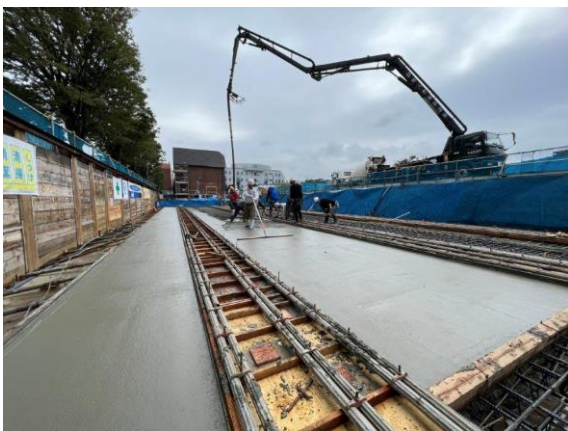
写真5 曳家経路耐圧盤設置の様子
