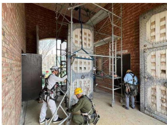
写真1 南面木製大扉解体の様子
