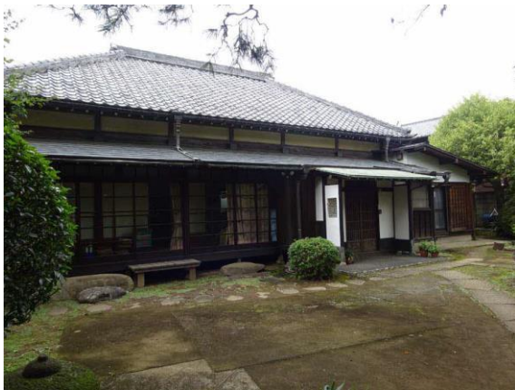
写真1 解体前の様子
