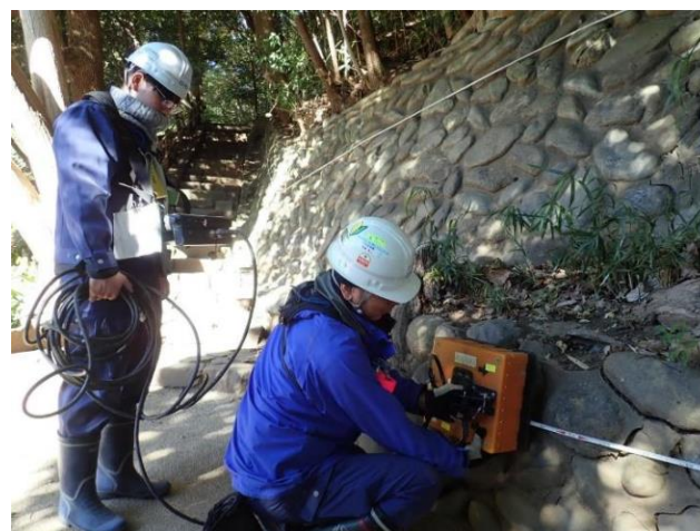
写真9 レーダー探査作業風景
