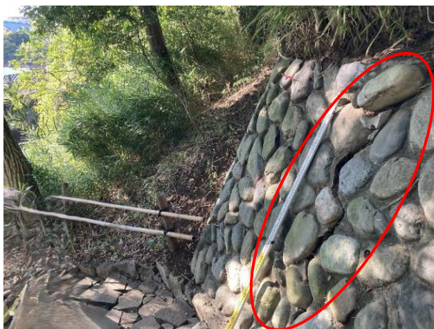
写真6 石積の亀裂
