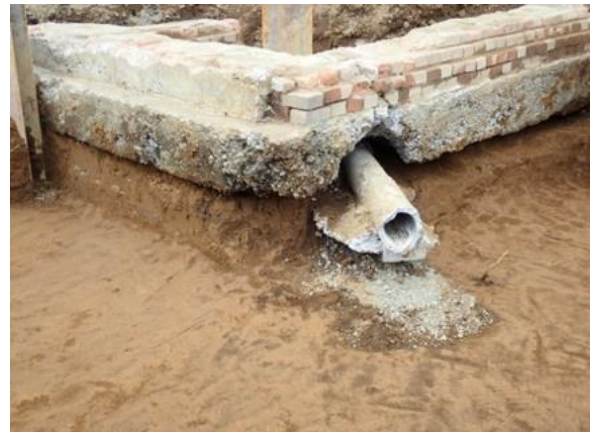
写真3 十字舎房基礎断面
