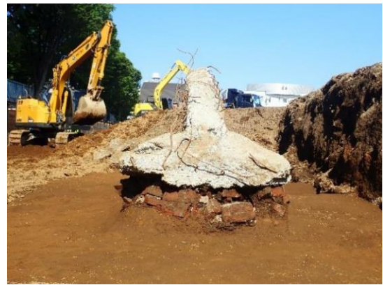
写真5 2期コンクリート塹基礎断面
