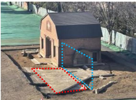
写真1 コンクリート仮塀を用いた道路面
