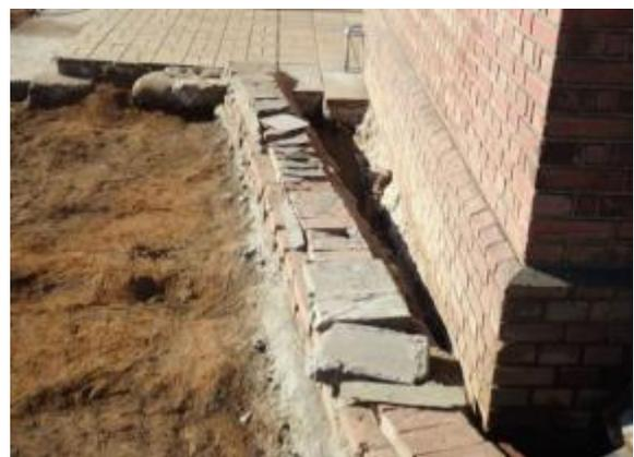
写真2 煉瓦を用いた溝
