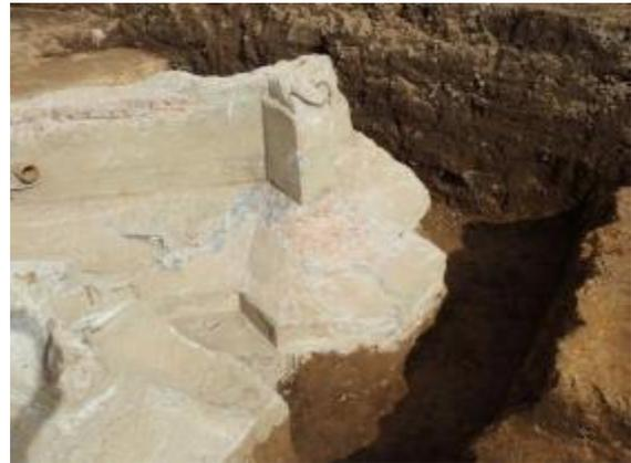
写真4 煉瓦混コンクリート塀基礎
