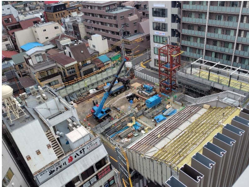
桃園広場側の工事状況
