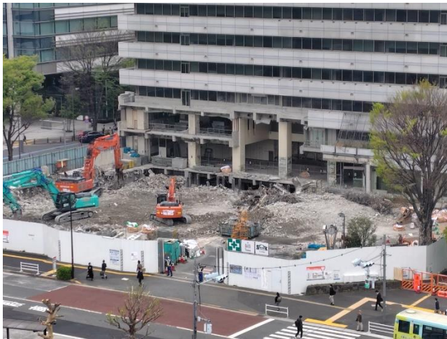
旧区役所低層棟の解体状況
