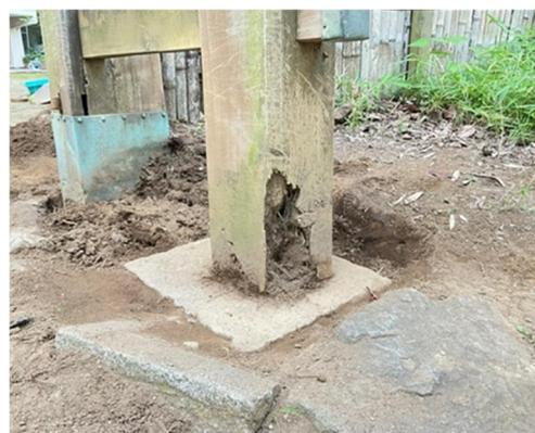
控柱の腐朽状況
