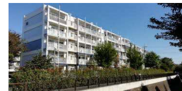
築60年以上経過した既存住棟
