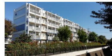
築60年以上経過した既存住棟
