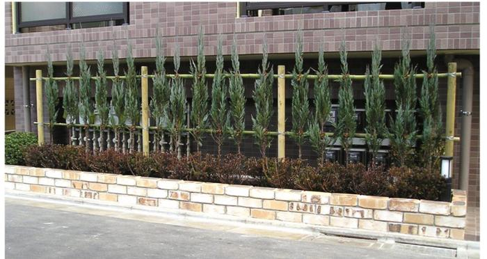
一定の間隔（通常 1.8m）で一列に打ち込んだ丸太に竹を横に取り付け（通常 2 段程度）この横竹の部分に植栽樹木を結束するものです。
