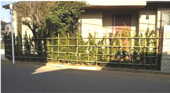
一定の間隔（通常 1.8m）で一列に打ち込んだ丸太に竹を横に取り付け（通常 3 段程度）さらに、この部分に竹を縦に交互にさして格子状にした垣根をいいます。
