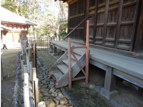
写真 4-12：階段と仮設の手すり (2022. 11. 14 撮影)
