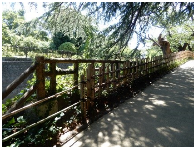
写真 4-167 : 妙正寺川沿いの擬木柵 (2022. 07. 30 撮影)
