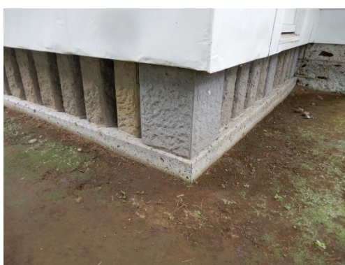
写真 4-33 : 東石の修復状況 (2022. 07. 30 撮影)
