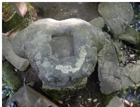
写真 4-52 : 火袋の消失状況 (2022. 07. 08 撮影)
