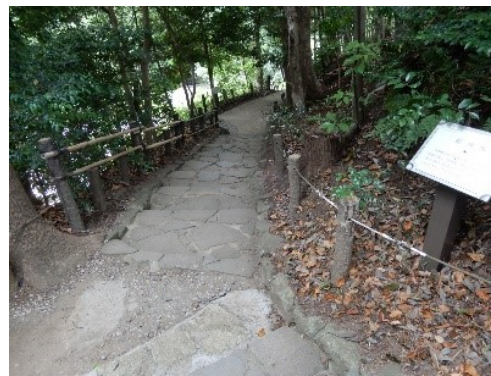
写真 4-85：経験坂と周辺の状況 (2022. 07. 08 撮影)
