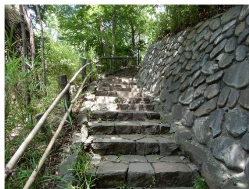
写真 4-128 : 斜面の通路の景観 (2022. 07. 30 撮影)
