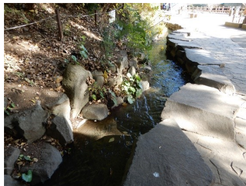
写真 4-57 : 進化溝と周辺の状況 (2022. 11. 14 撮影)
