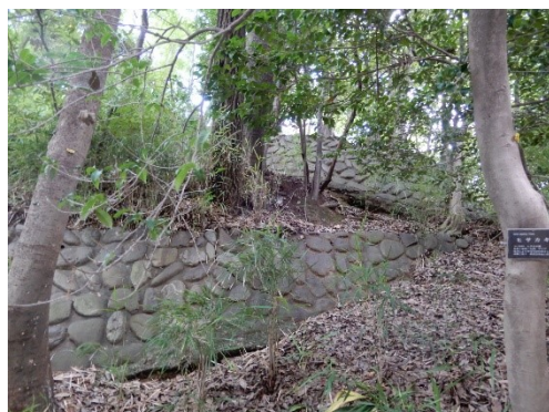
写真 4-127 : 斜面に設置された石積の景観 (2022. 07. 30 撮影)
