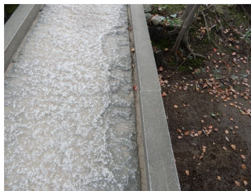
写真 4-35 : 修復後の状況 (2022. 07. 30 撮影)
