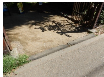
写真 4-162 : 下田橋口の段差解消 処理の状態 (2022. 07. 30 撮影)
