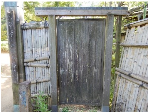
写真 4-5 : 常識門の聯と通用門と建仁寺垣 (2022. 07. 30 撮影)
