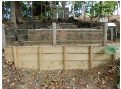
写真 4-83 : 板柵と擬木ロープ柵の状況 (2022. 07. 08 撮影)
