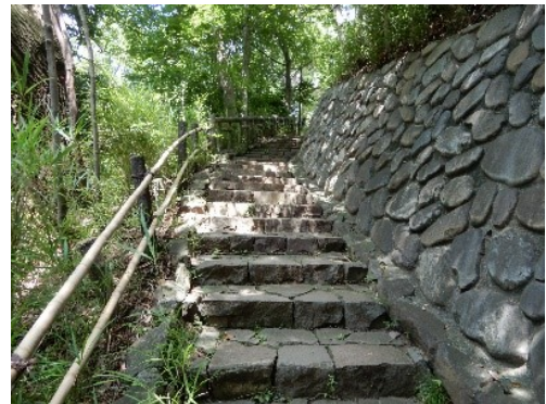
写真 4-89：認識路と周辺の状況 (2022. 07. 08 撮影)
