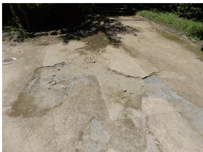
写真 4-160 : 舗装表面の状態 (2022. 07. 30 撮影)
