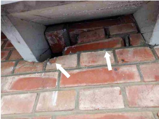
図 1-41 西面壁頂部の煉瓦積破損
