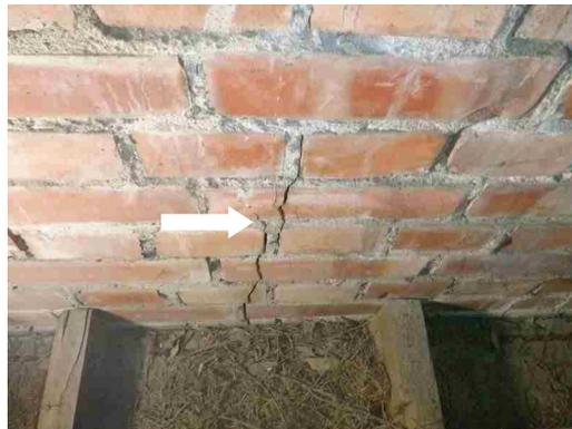
図 1-32 元守衛室東面のひび割れ(天井裏)
