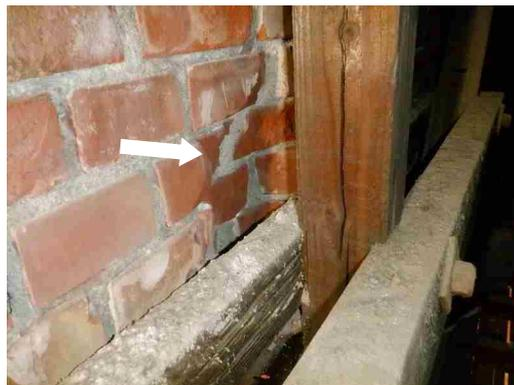
図 1-48 小屋裏北面 煉瓦の部分欠損
