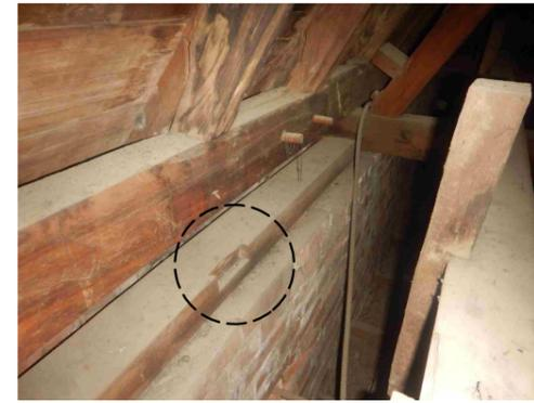
梁天端の欠き込み+釘穴痕跡
