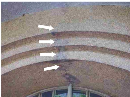
図 1-33 東面アーチ開口上部のひび割れ
