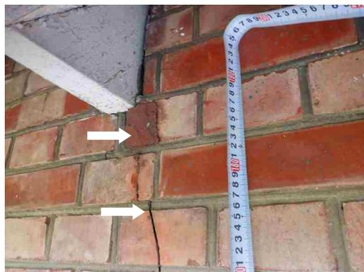
図 1-34 東面壁頂部のひび割れ
