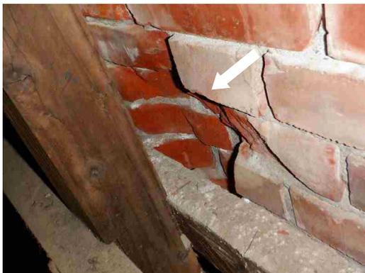
図 1-47 小屋裏北面 煉瓦の部分欠損
