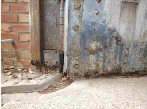
図 1-78 南面大扉鉄板の腐食、木部の腐食
