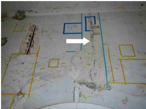
図 1-31 元守衛室東面のひび割れ
