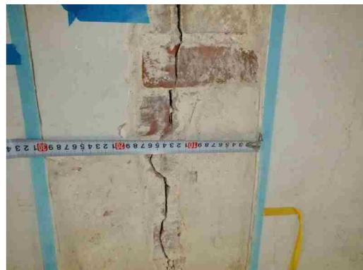
図 1-24 元守衛室東面のひび割れ
