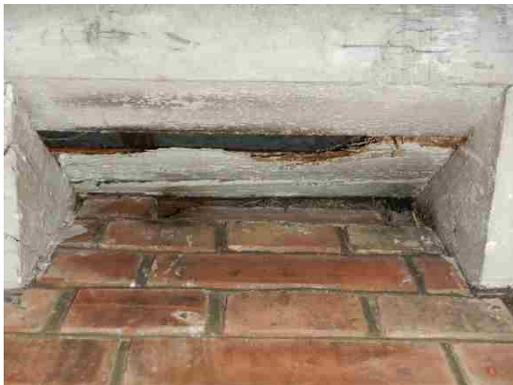
図 1-73 化粧軒裏の腐朽
