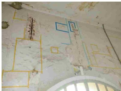
図 1-56 元守衛室東面 仕上げ材の浮き
