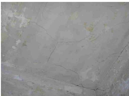
図 1-63 部屋天井 漆喰のひび割れ・塗装剥離
