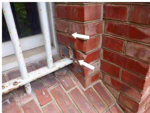
図 1-36 南面開口部 金物周りのひび割れ・破損
