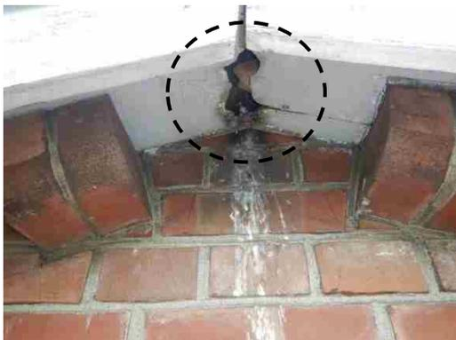
図 1-75 けらば側の厚板の軒裏の腐朽
