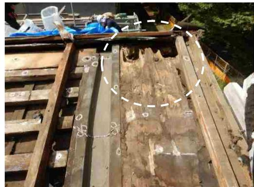
図 1-74 けらば側の厚板の腐朽
