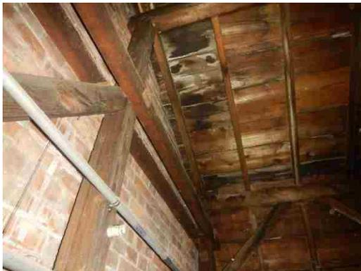
図 1-67 野地板の雨染み跡、白色変色
