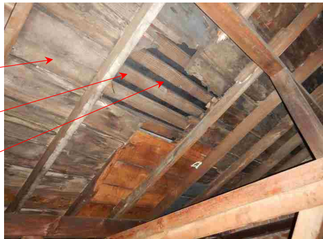
[屋根下地状況]
