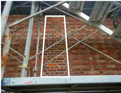
図 2-1-05 西面外部の目地補修跡
