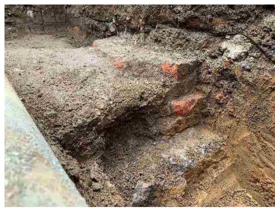
図 2-2-7 創建時の煉瓦塀の基礎
