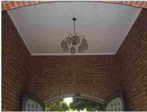
写真7 中央通路天井部分（北側から）
