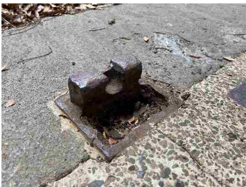
図 2-1-61 南面大扉の戸当たり金物 上面に半円形の窪みのある戸当たり金物が残る
