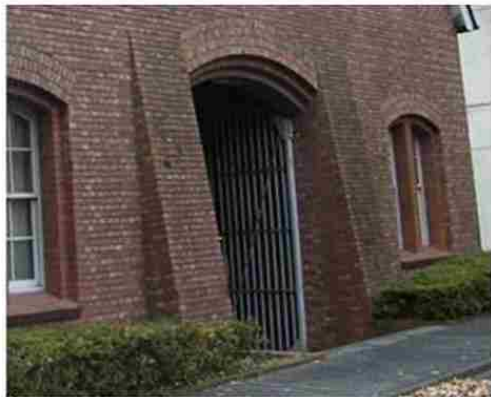
写真3 裏西側（ファザード部分）
