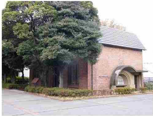
写真1 正面側（南東側から）
