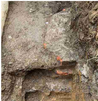
図 2-2-6 創建時の煉瓦塀の基礎
