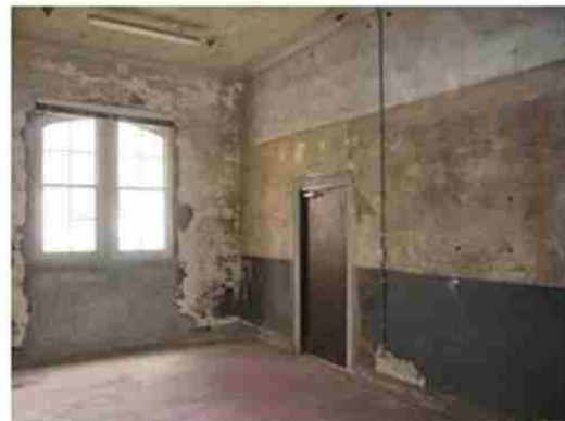
写真12 西側部屋内部（南側から）
