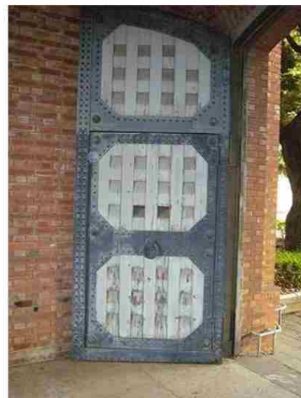
写真6 正面扉の仕様（東側の扉）
