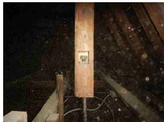
図 2-1-48 ボルトのゆるみ
