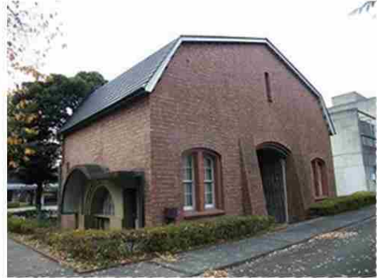
写真2 裏西側（北東側から）
