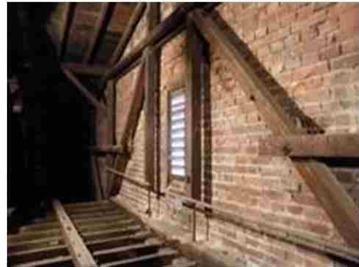
写真10 天井裏小屋組（裏面西側）
