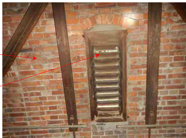
[北面 小屋裏換気口]
