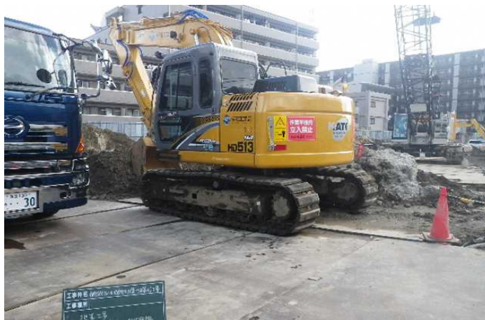
車両名:バックホー 解体工事や掘削の際に使用します。
