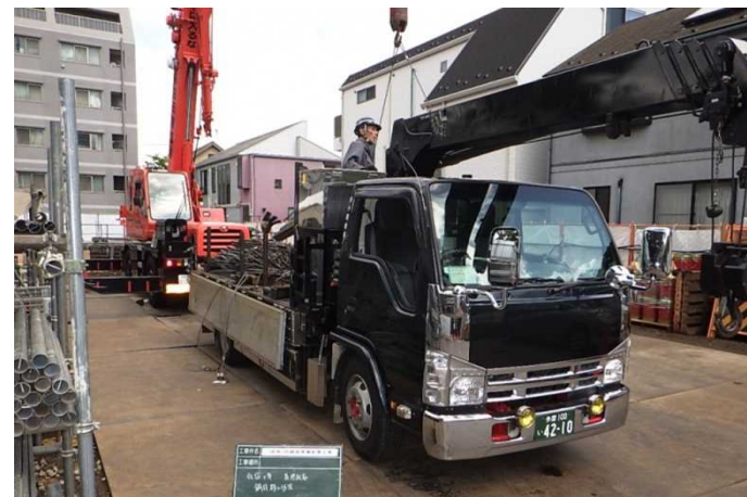
車両名:ユニッククレーン車 トラックにクレーンが付いており、資材を運搬する際に使用します。
