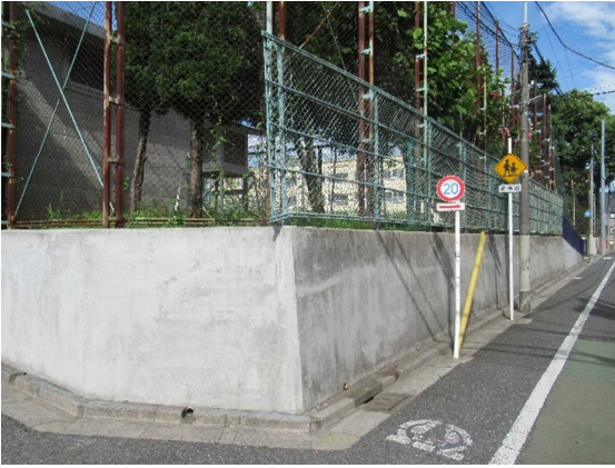
③東側敷地 南西角の校庭と道路の高低差は1.8m程
