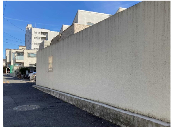
⑧西側敷地 西面道路 塀には消防用の採水口がある
