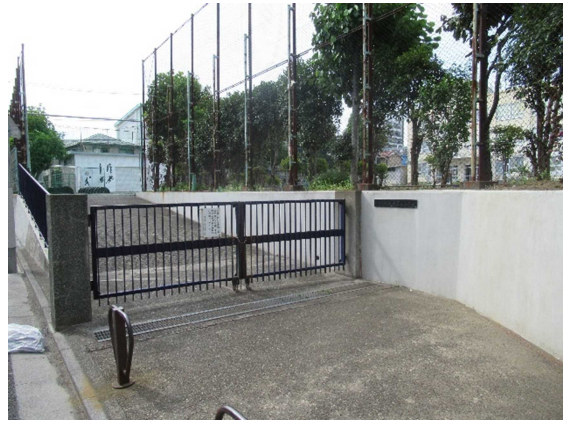
④東側敷地 南面の入口、スロープ
