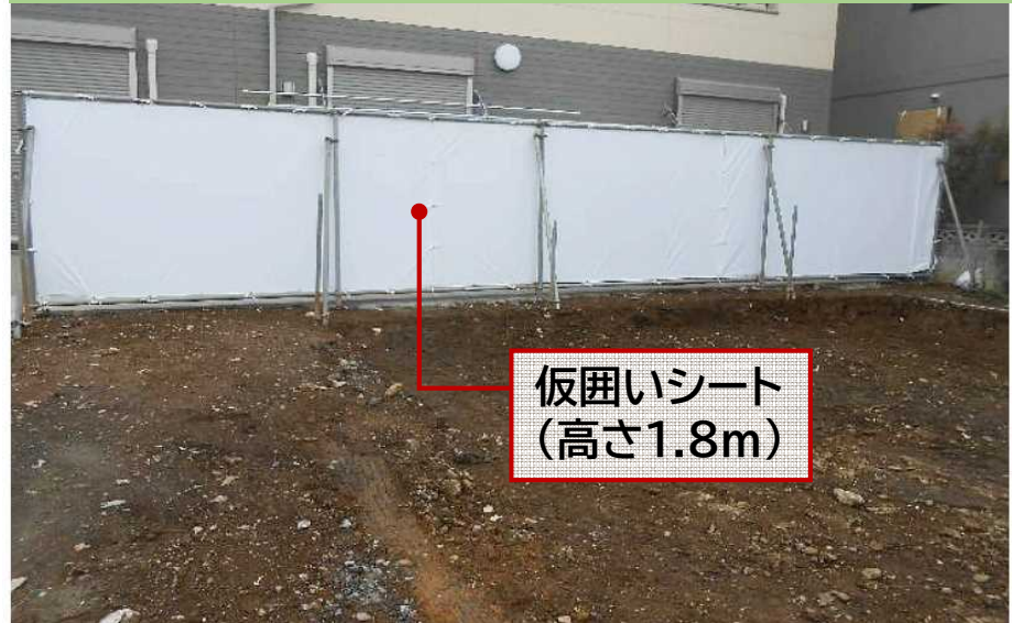
仮囲いシート 設置状況(参考)
