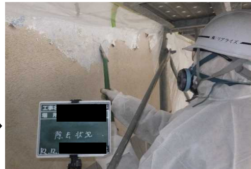
③手工具ケレン工法
