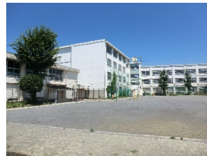
⑪体育館と校舎
