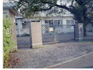
③北側搬入門
