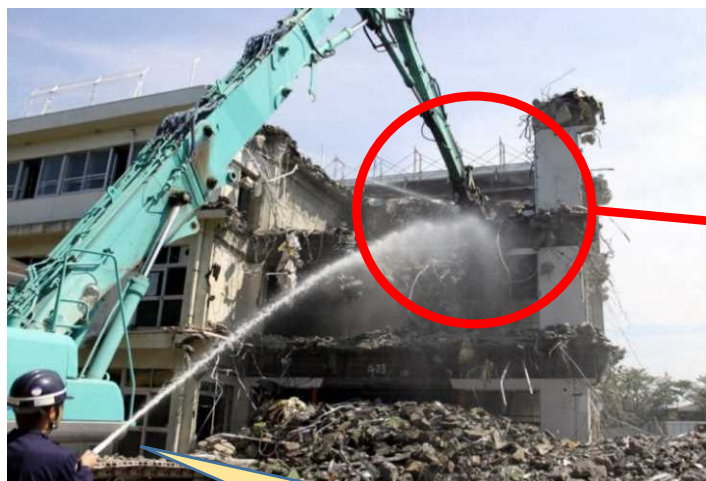
散水による粉塵飛散抑制
