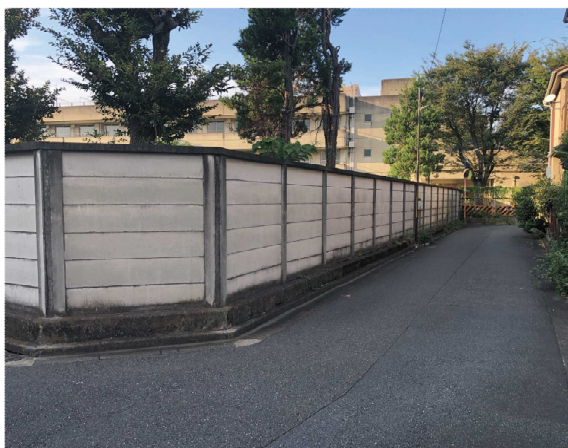
⑦南側道路(敷地中央付近)
