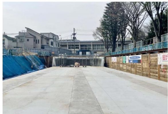
写真2 曳家経路と曳家先
