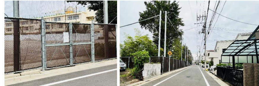
③南東側（校庭用の扉） ④南東側
