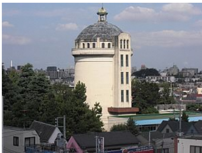
野方配水塔(南東側から望む)
