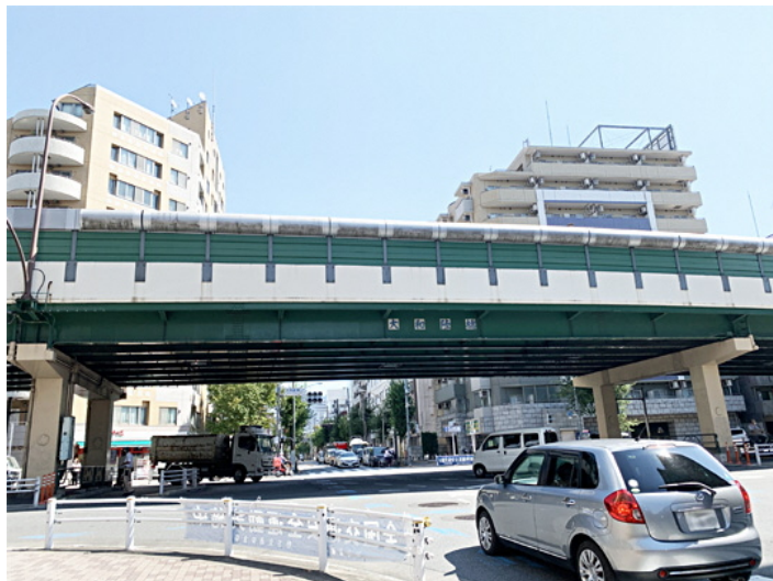
大和陸橋(大和町側から撮影)
