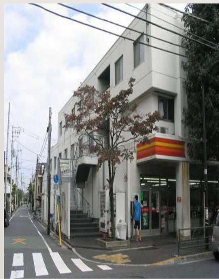
外壁塗装工事（Before）
