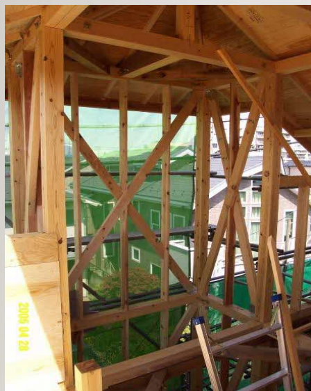
耐震補強工事
