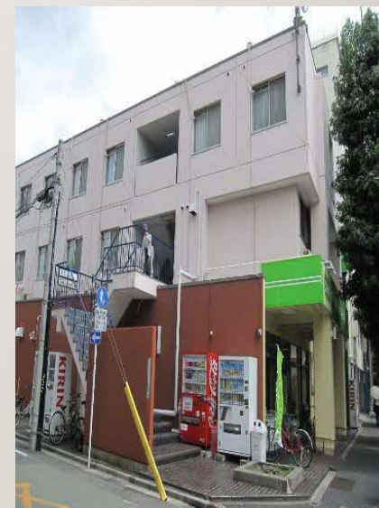
外壁塗装工事（After）
