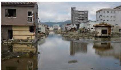
津波の爪痕が残ったままの街並み 東北地方太平洋沖地震(平成23年)
