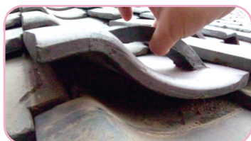
屋根瓦の葺き土の有無を調査
