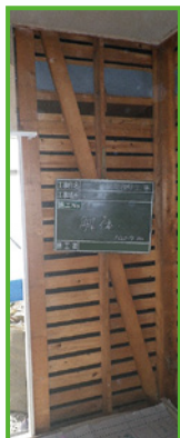
①既存壁の撤去
