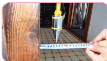
下げ振りで柱の傾きを調査
