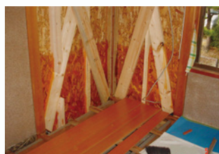
押入れ内補強
