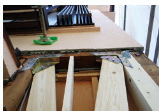
通し柱補強（室外より）
