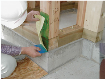
柱脚補強 (30cmシート1枚貼り)
