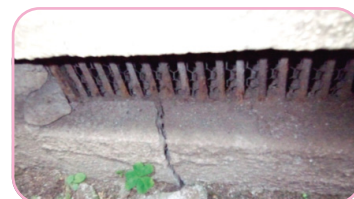
基礎のひび割れを調査
