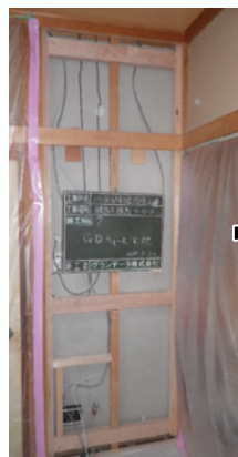
合板受材施工
