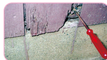
土台の腐朽度合いを調査
