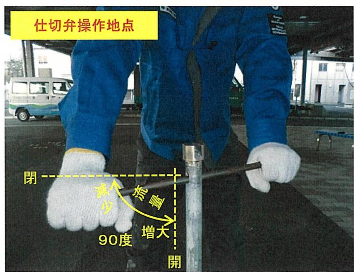
空気が完全に抜けたら、排水作業地点との合図により流量調整を行います。流量調整は、仕切弁の回転角度で調整します。仕切弁は最大90度まで回転しますが、まず等から水が溢れない程度に、流量を調整します。
