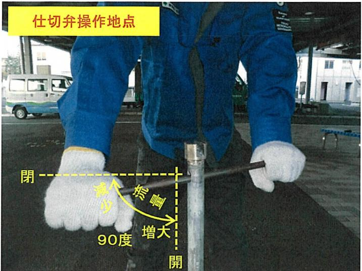
空気が完全に抜けたら、給水作業地点との合図により、仕切弁を更に左に回し仕切弁を全開にします。緊急時に、すぐに止水ができるように、水を出している間は、開栓器は仕切弁に設置したままにしておきハンドルは折たたんだ状態にします。
