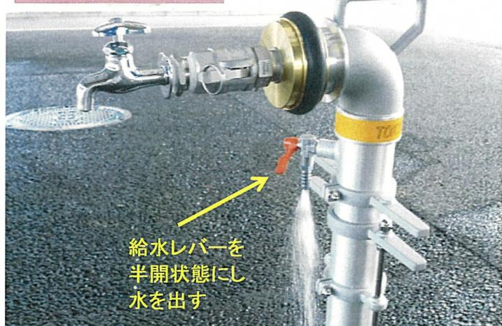
応急給水作業が終了したら、給水レバーを半開状態にして水を出します。
