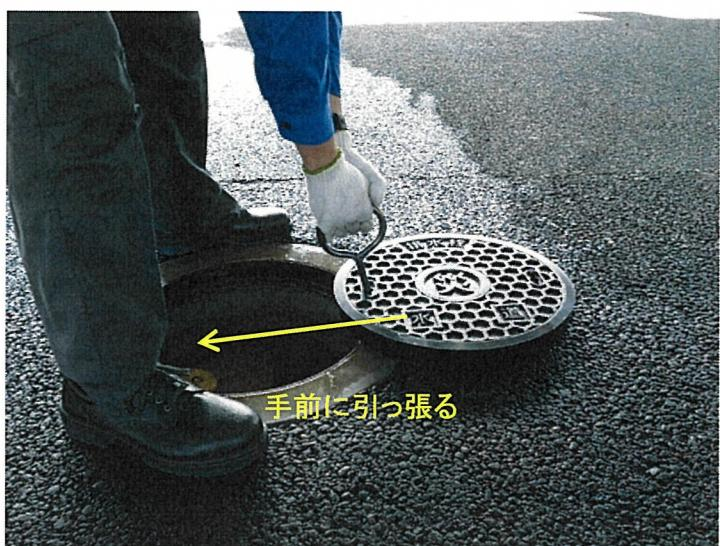
鉄蓋の鍵穴に、蓋鍵をセットして抜けないように引っ掛けます。
