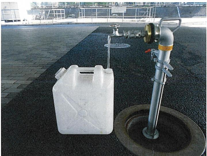
応急給水作業の実施状況です。応急給水作業は、蛇口アダプターや、給水レバーを使用して行います。写真は、蛇口アダプターによる応急給水作業です。
