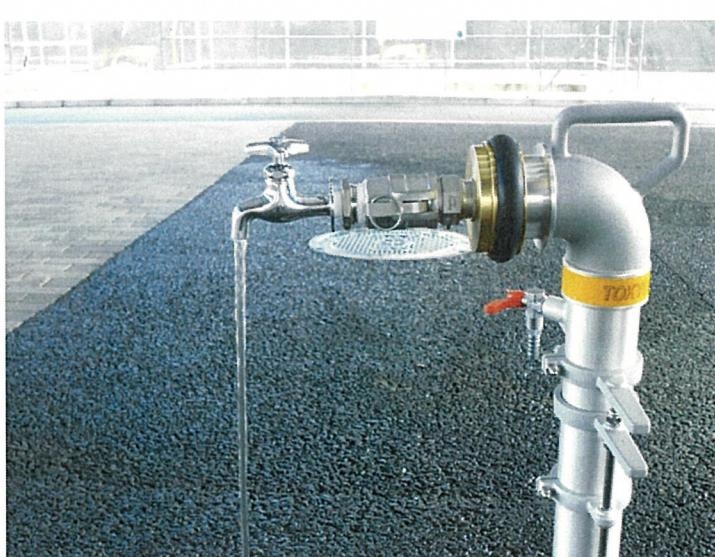
蛇口アダプターでも、蛇口を左に回し、空気を抜きます。
