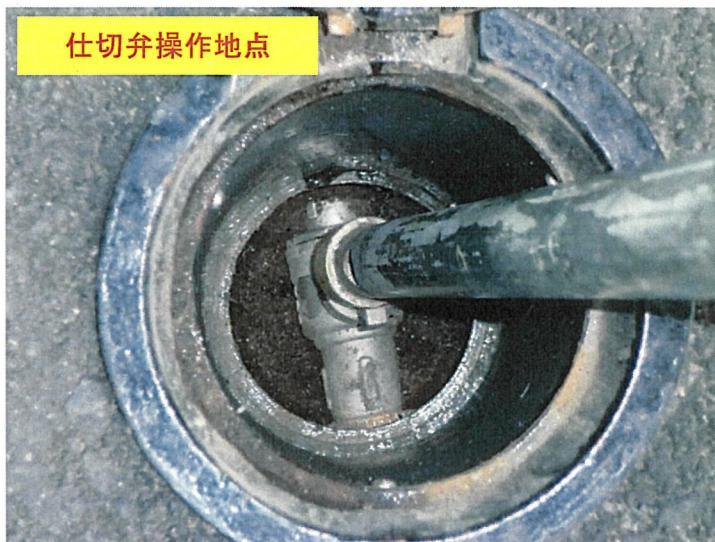
開栓器の仕切弁操作用鍵穴を、仕切弁の凸部にセッティングします。
