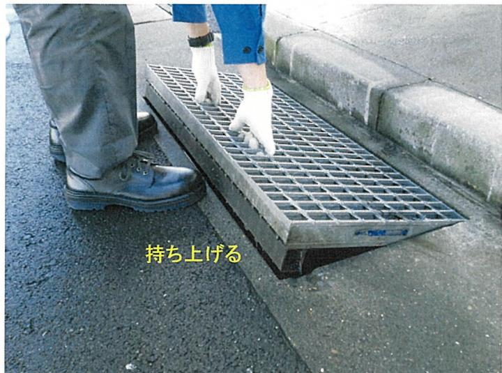
排水作業では、濁っている水をきれいになるまで吐き出すため、雨水ます等を使用して作業を行います。またの形状や大きさ、種類には様々なものがあります。写真は、雨水用の集水ますです。ますの蓋を持ち上げ取り外します。
