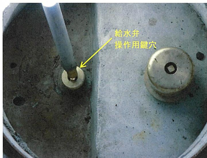
開栓器の給水弁操作用鍵穴を、給水弁の凸部にセットします。
