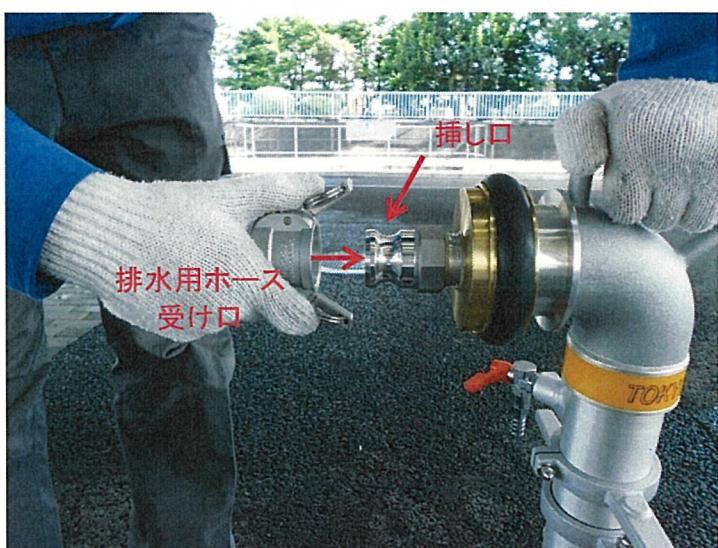
接続金具の挿し口に、排水用ホースの受け口を接続します。
