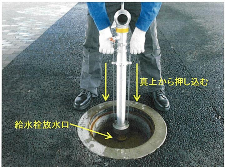
給水栓放水口にスタンドパイプを設置します。
