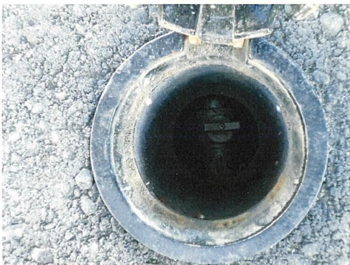
蓋の中に仕切弁が設置されていることを確認します。
